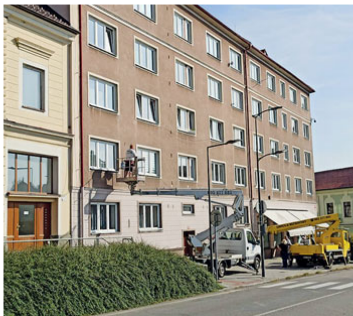
V polovině září začala realizace 1. a 2. etapy nátěru fasády bytového domu Na Růžku.
