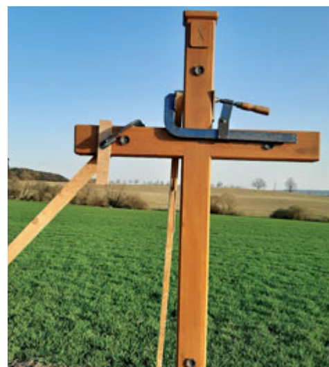
Snímek zachycuje instalaci jednoho z dřevěných křížů.
