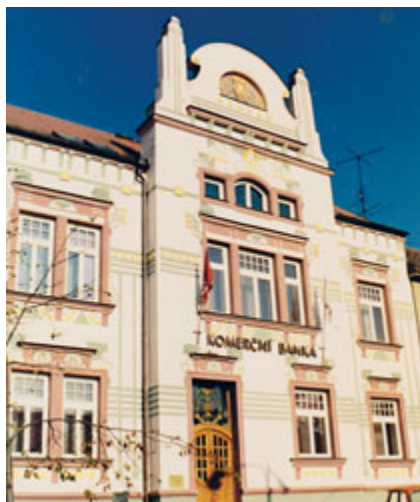
Průčelí secesního domu čp. 156 po rekonstrukci v roce 1993, kdy tam byla umístěna Komerční banka. Foto z roku 1995. (František Panec)
