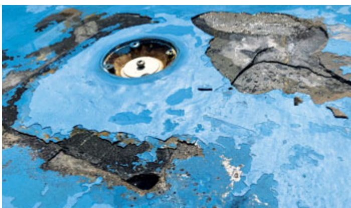
Po letech užívání vykazují bazény na koupališti značné vady. Před zahájením sezóny tak musí dojít k rozsáhlé a nákladné opravě. V rámci renovace náterů dojde také k malbě plaveckých drah.
