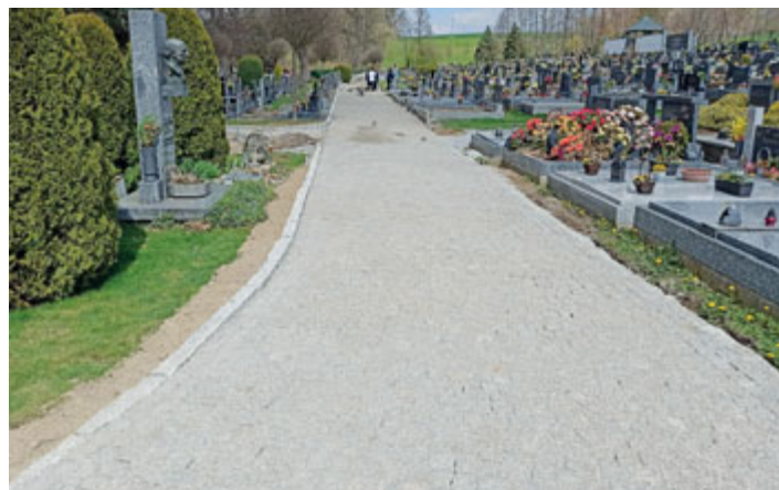
Začala druhá etapa rekonstrukce chodníků na milevském hřbitově.
