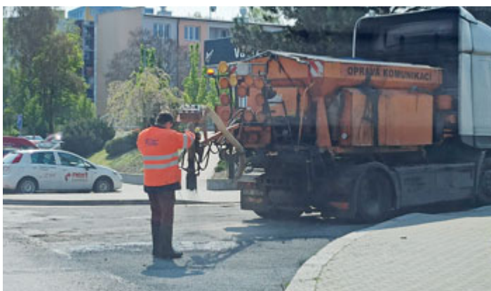
Na čtyřech místech města (Písecké předměstí, Vzor, ul. B. Němcové a Masarykova) proběhla oprava komunikací tzv. tryskovou metodou.
