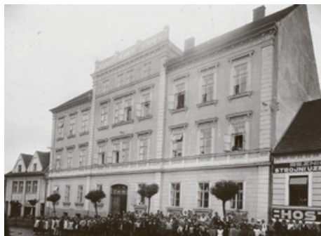
Stará škola, budova nynějšího gymnázia (30. léta 20. století).
