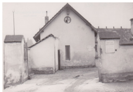
Vstupní brána do milevských jatek čp. 416 v Sokolovské ulici. Játka dnes už neexistují, na jejich místě stojí rozsáhlý bytový dům postavený v roce 1997 firmou Polata. Foto z roku 1966. (Milevské muzeum)
