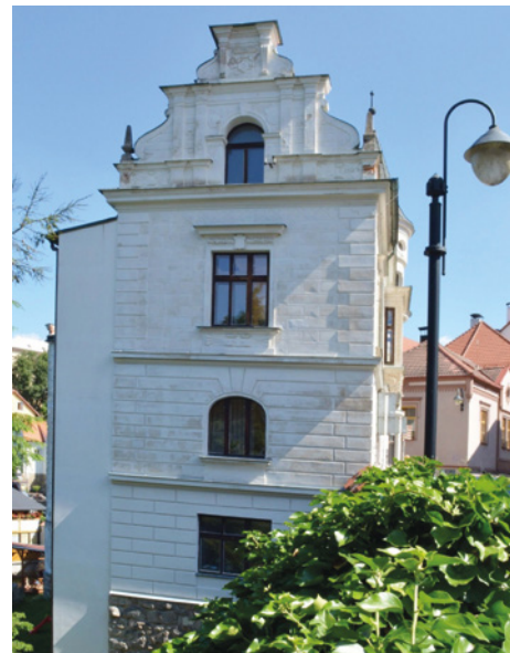
Vila Libuše čp. 744 v Klokotské ulici v Táboře, stav v roce 2016. (Foto autor)
