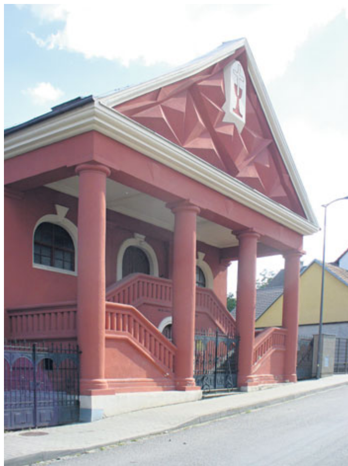
Synagoga po rekonstrukci v roce 2010, kdy byla provedena oprava fasády, 2019.
