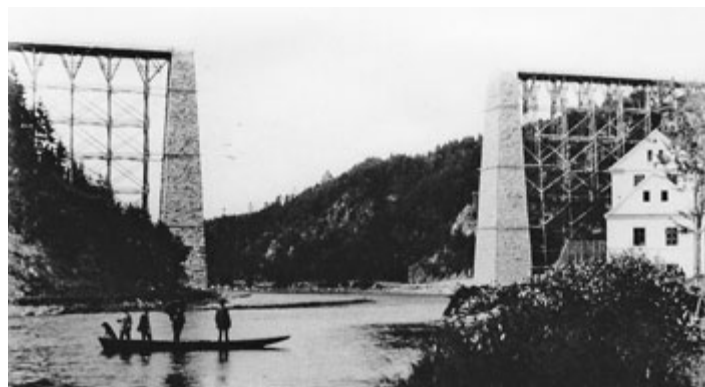
Stavba železničního mostu v Červené nad Vltavou foto z 30. 7. 1889.
